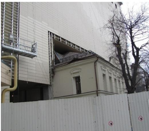
Рисунок 7 - Изменение функционального назначения здания объекта культурного наследия путем надстройки торгово-развлекательного центра, г. Воронеж
