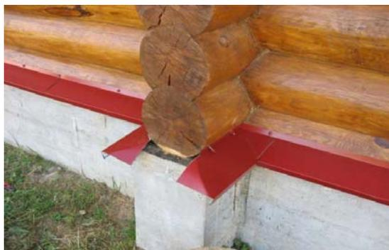
Рисунок 3 – Установка металлического отлива на сруб
